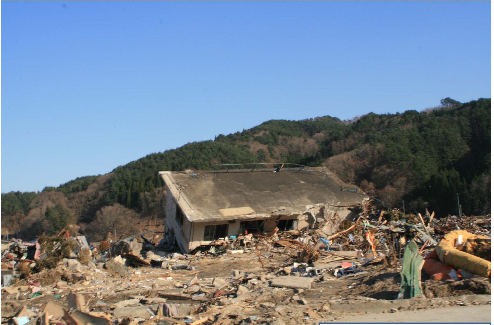
倒壊したRC家屋 織笠付近
