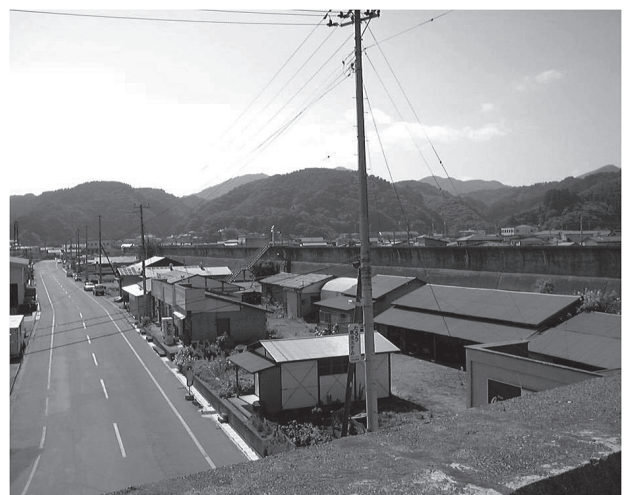
図3 第2防潮堤の外側の建物 (信夫隆司氏提供 1998年7月16日)
