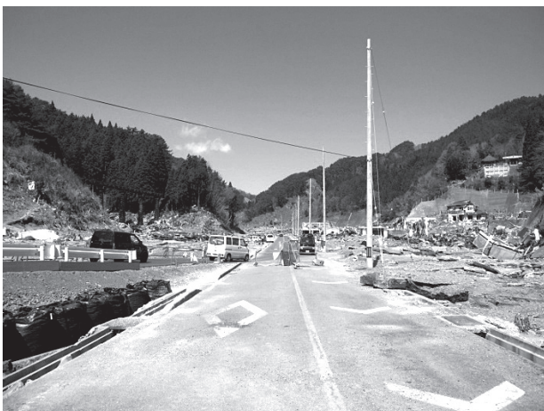
図8 全壊した釜石市両石地区（2011年4月17日）
