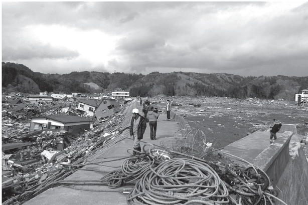
図4 被災直後の田老地区 (防潮堤左が第1防潮堤堤内地、右が第2防潮堤堤内地 2011年3月23日)
