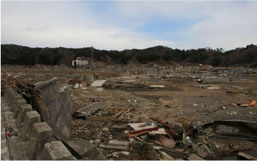
写真14 第2防潮堤の被災（右側が海）
