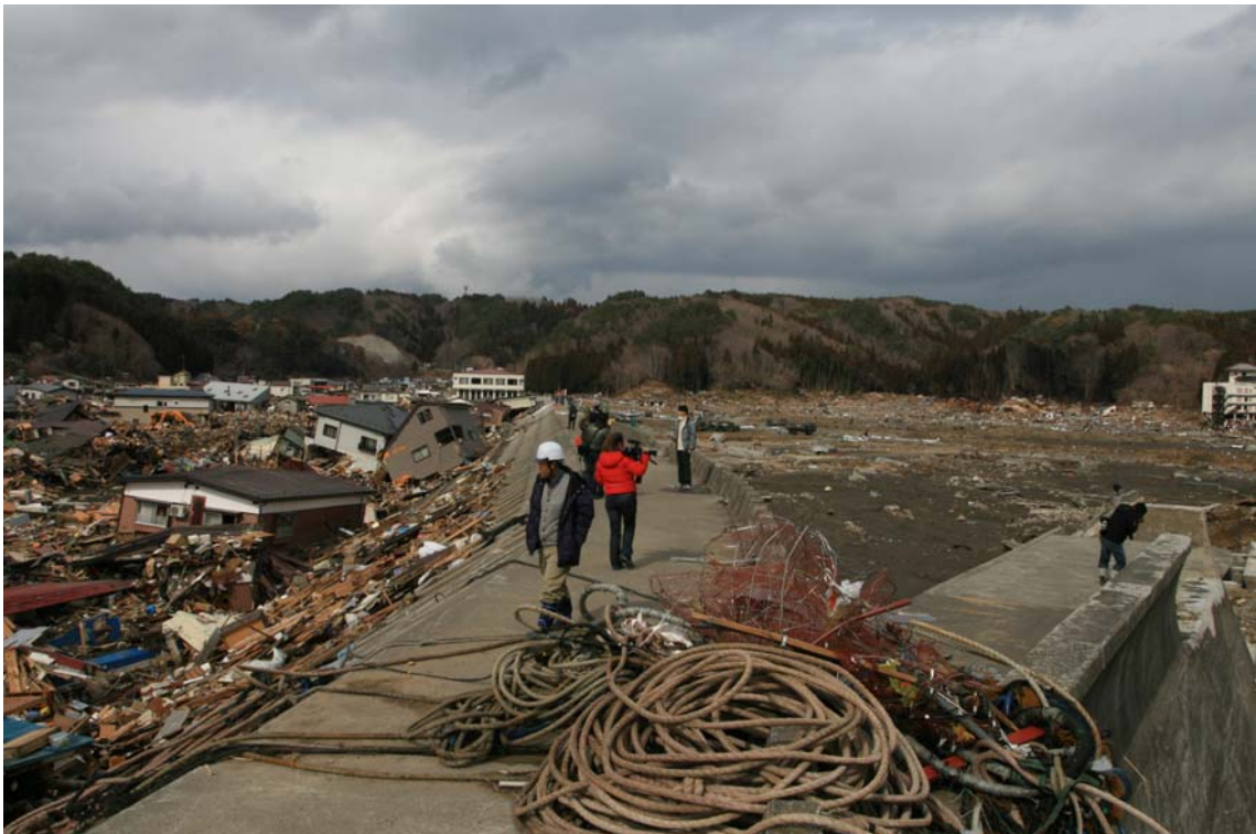
写真17 被災の比較（左側が破堤しなかった地区、右側が破堤した地区）
