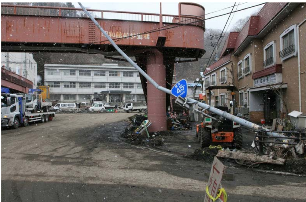
写真3 照明柱の被災（宮古市役所前）
