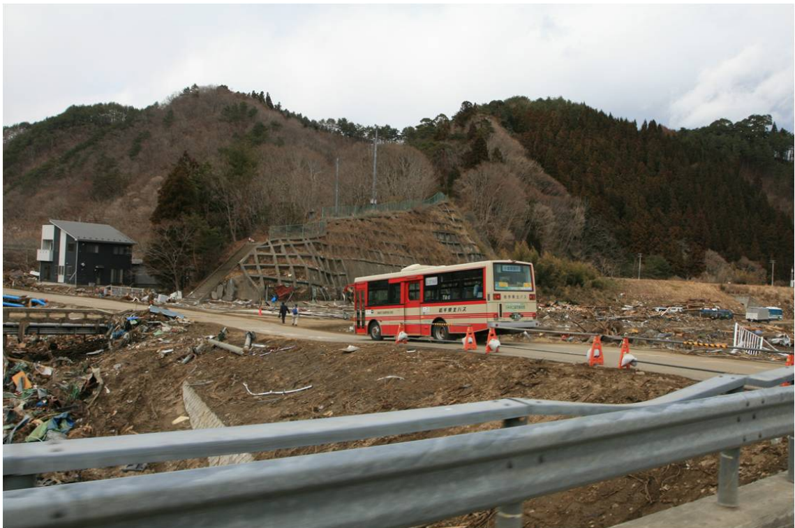
写真7 運行を再開した路線バス（田老地区）
