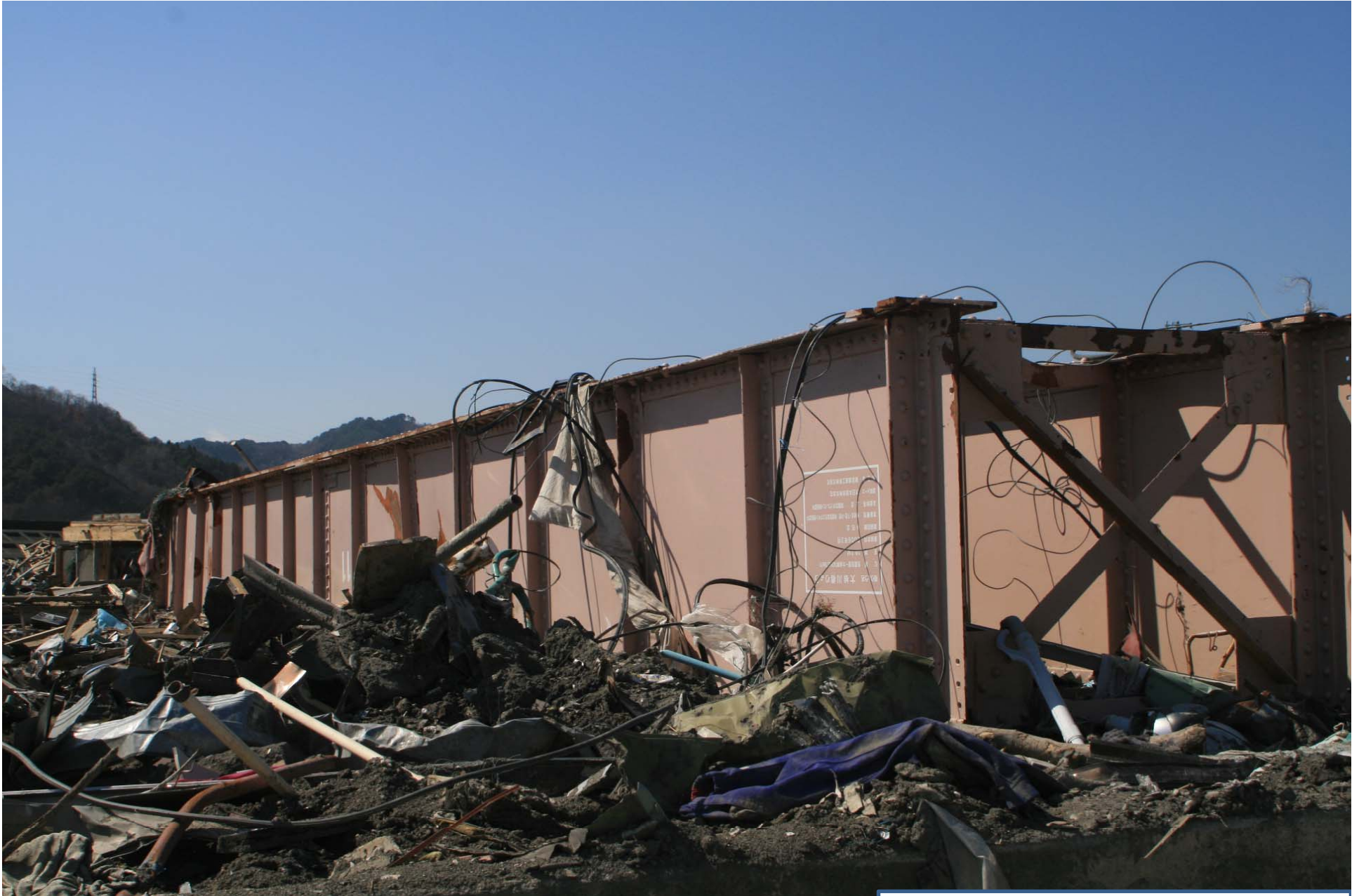
橋梁上部工 JR山田線新港町
