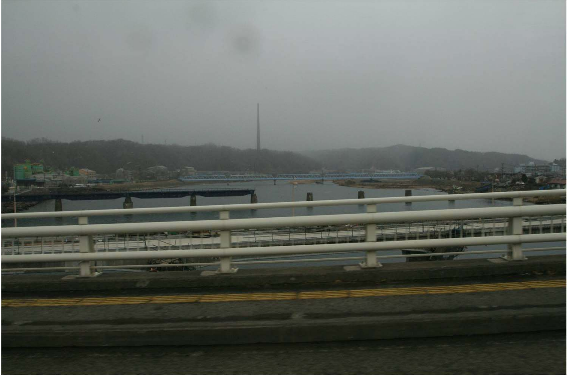
鉄道橋の被災(JR山田線)
