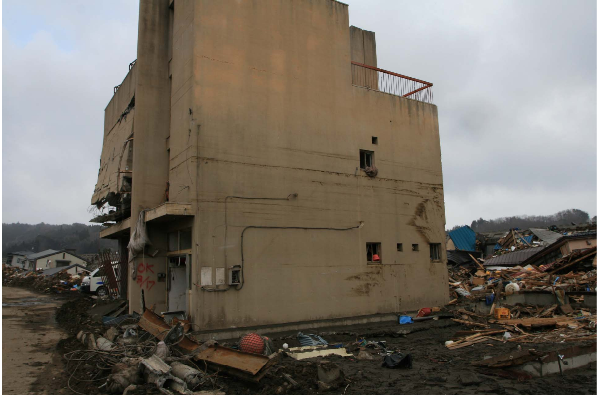
洪水痕跡(田老地区長内川右岸側)2階天井まで水没したと思われる
