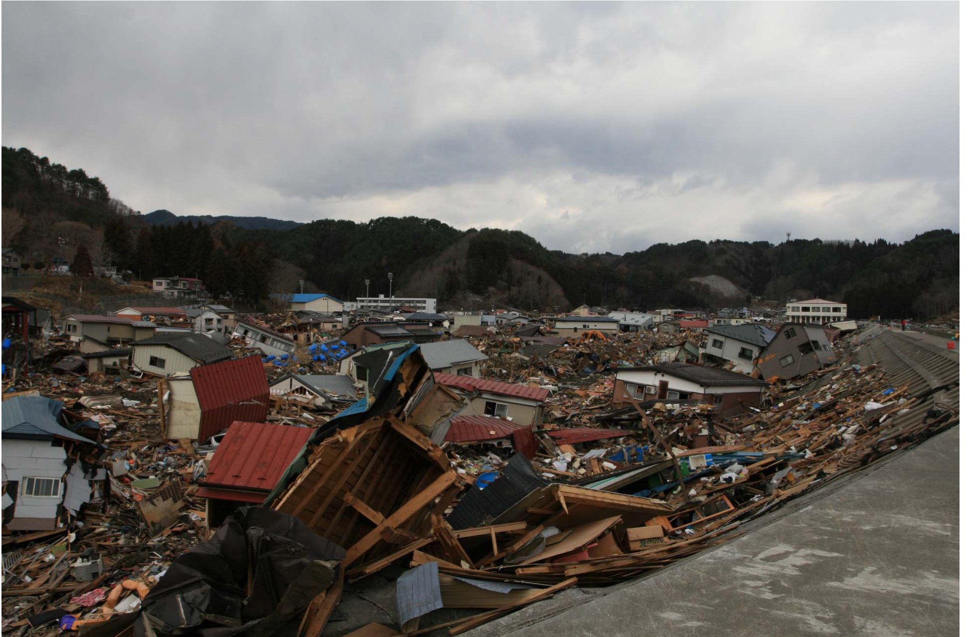
被災状況(田老地区長内川右岸)
