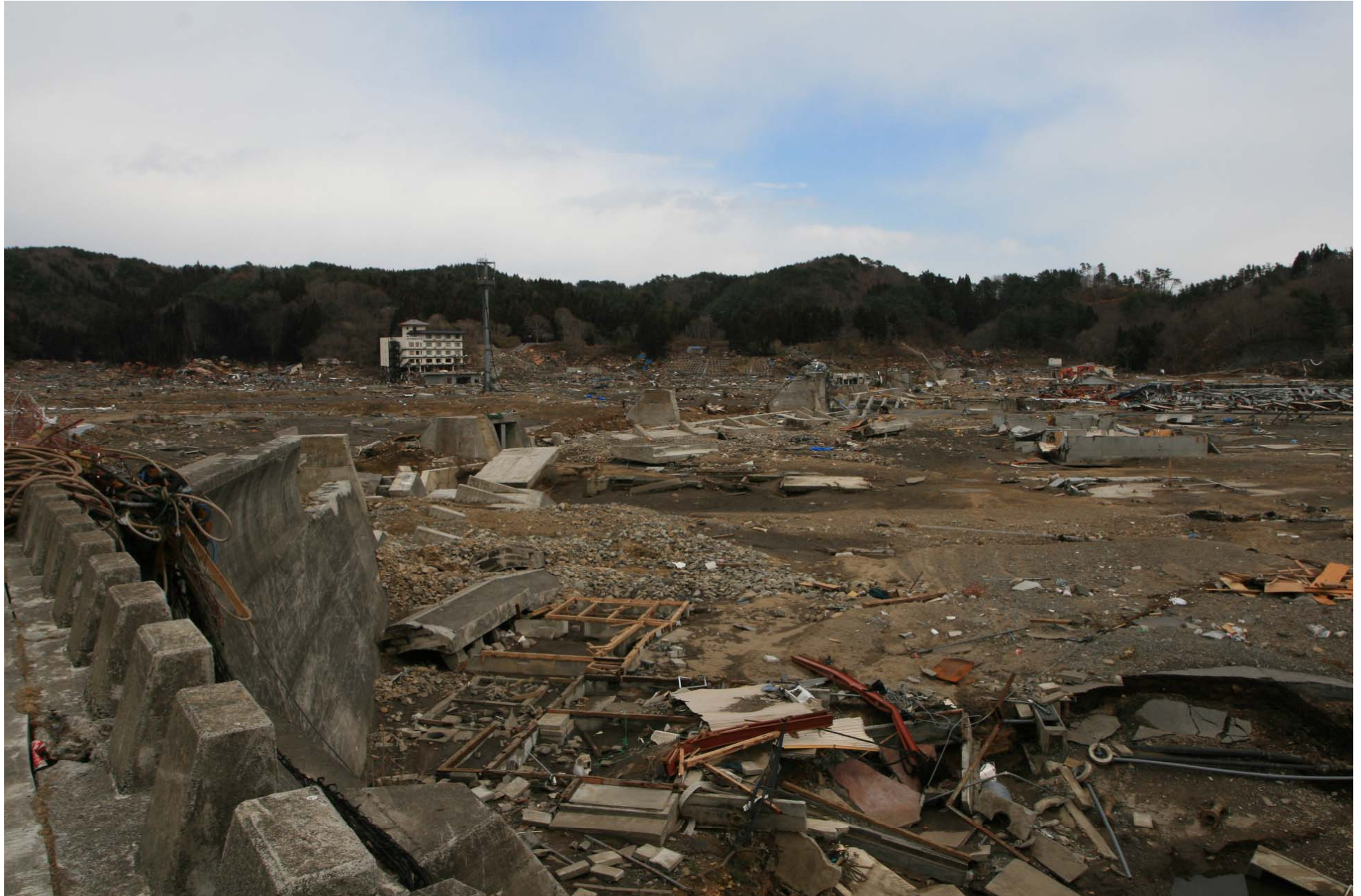
No.2 防潮堤の被災と長内川左岸の状況(田老地区 奥の建物はたろう観光ホテル)
