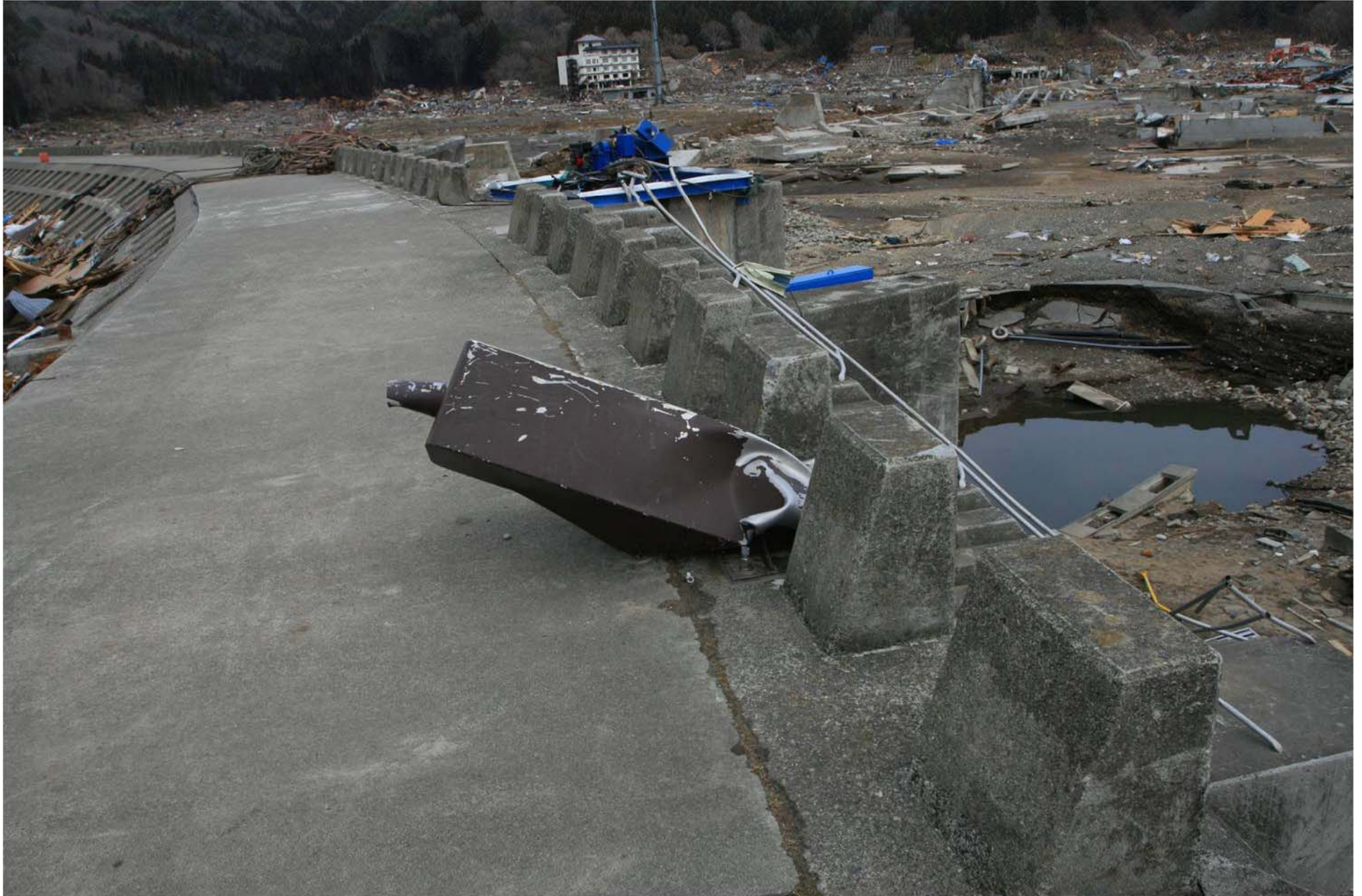
No.1防潮堤上の照明柱の被災(田老地区)
