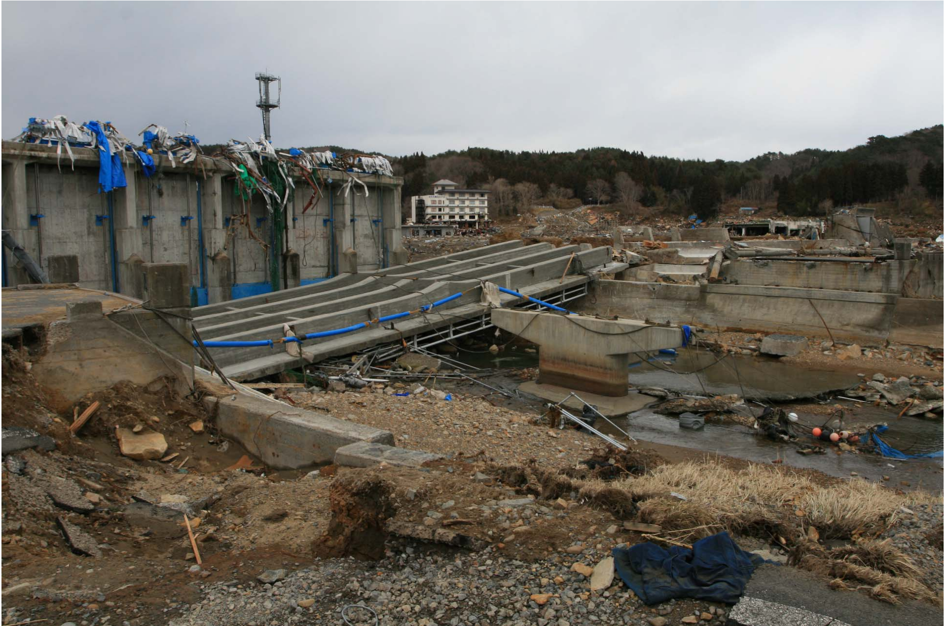
橋梁の被災(田老地区みなと橋)
