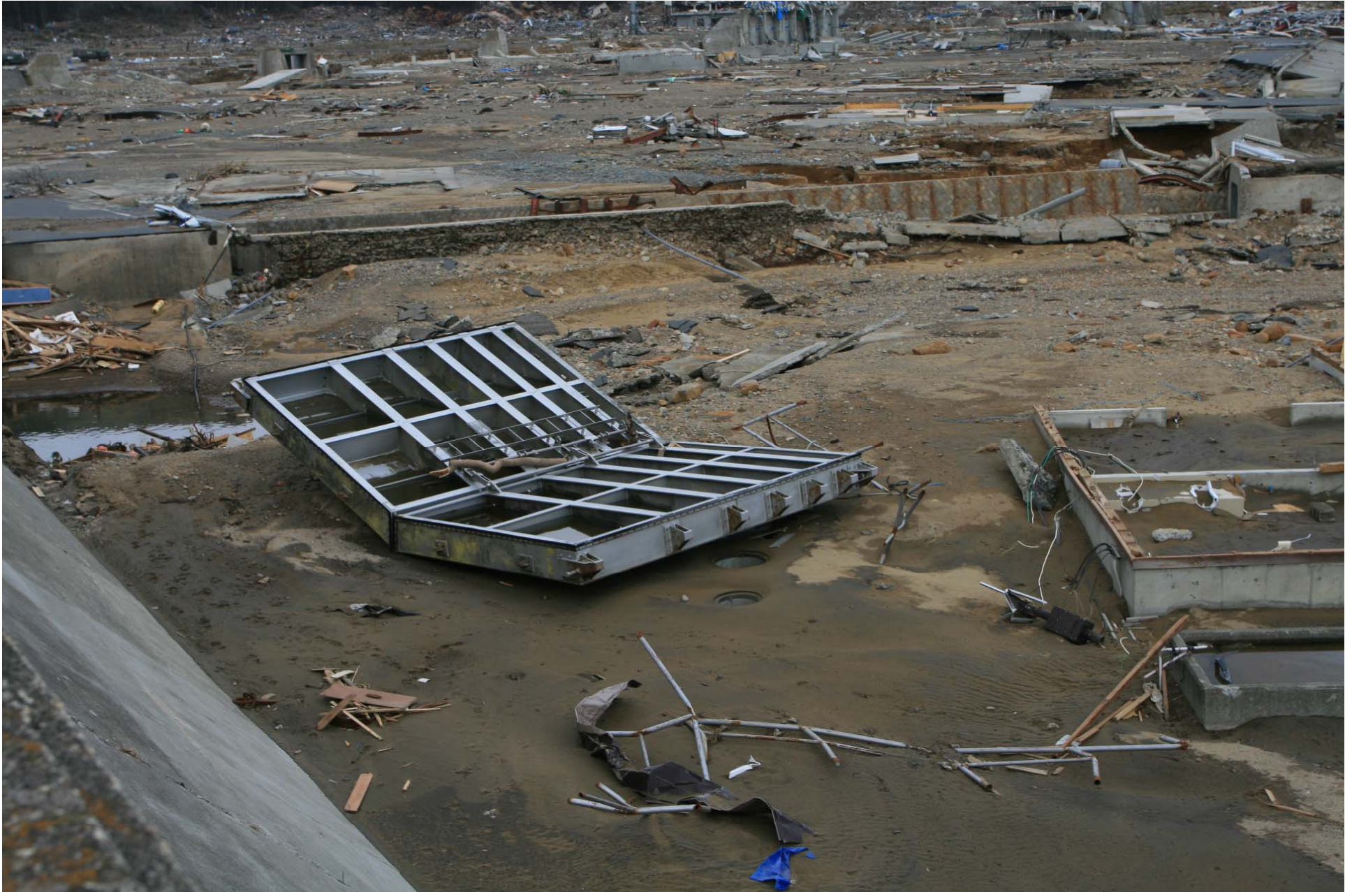
防潮扉の被災(田老地区)
