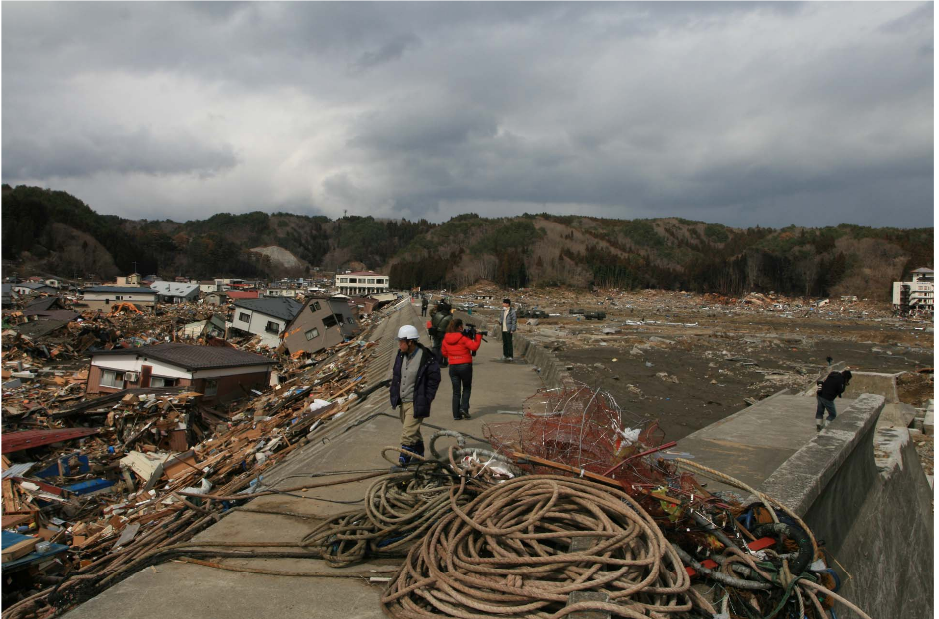
田老地区の被災(No.1防潮堤上から)
