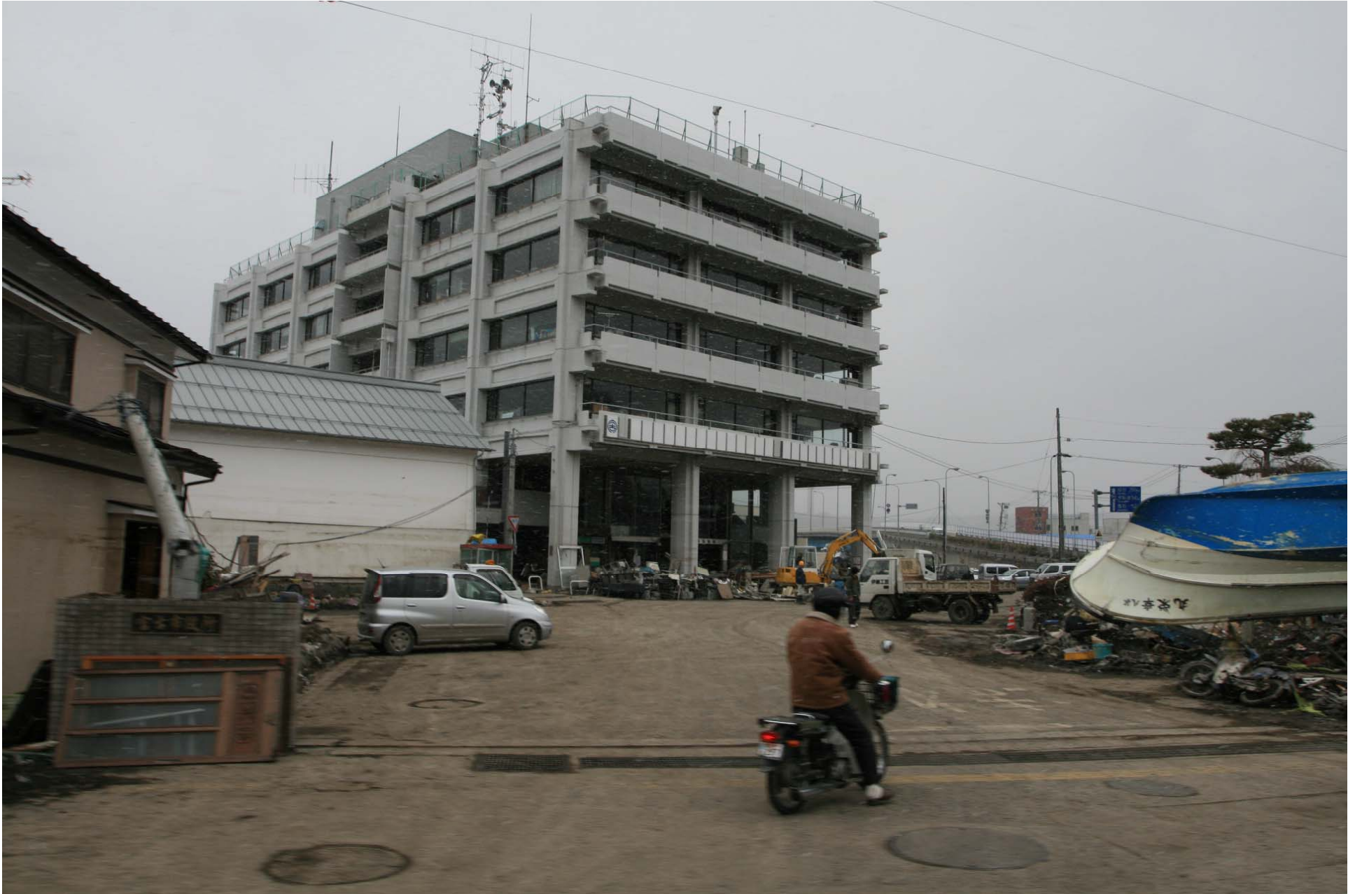
宮古市役所(1階部分が被災)
