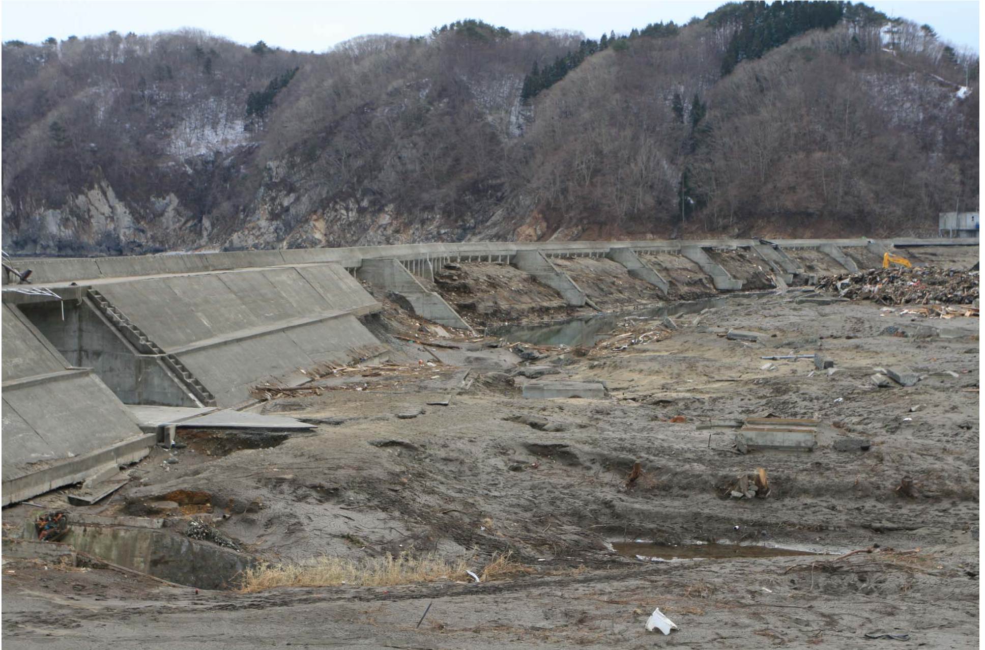
No.3防潮堤の被災(田老地区)
