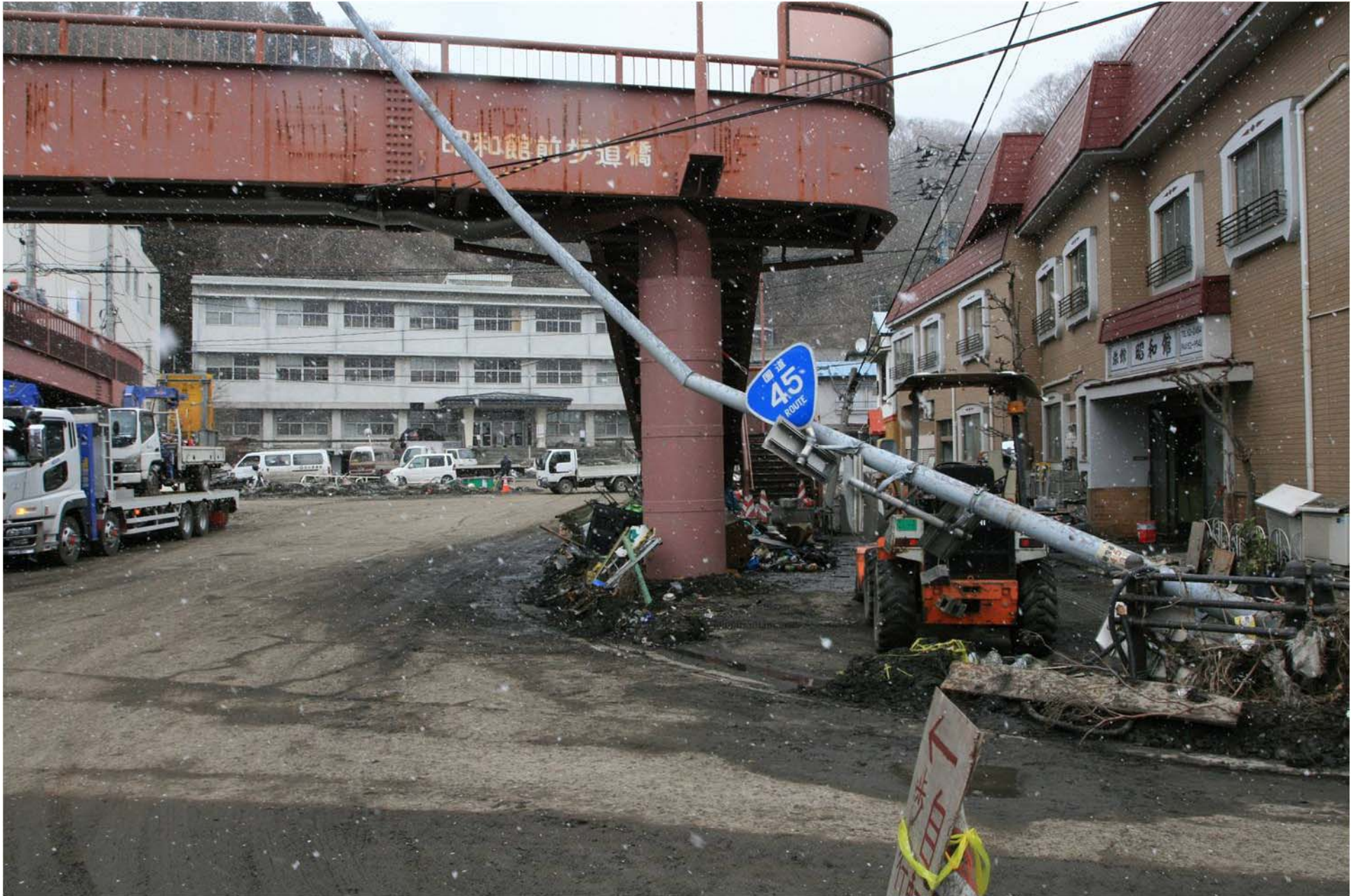
照明柱の被災(宮古市役所付近国道45号)
