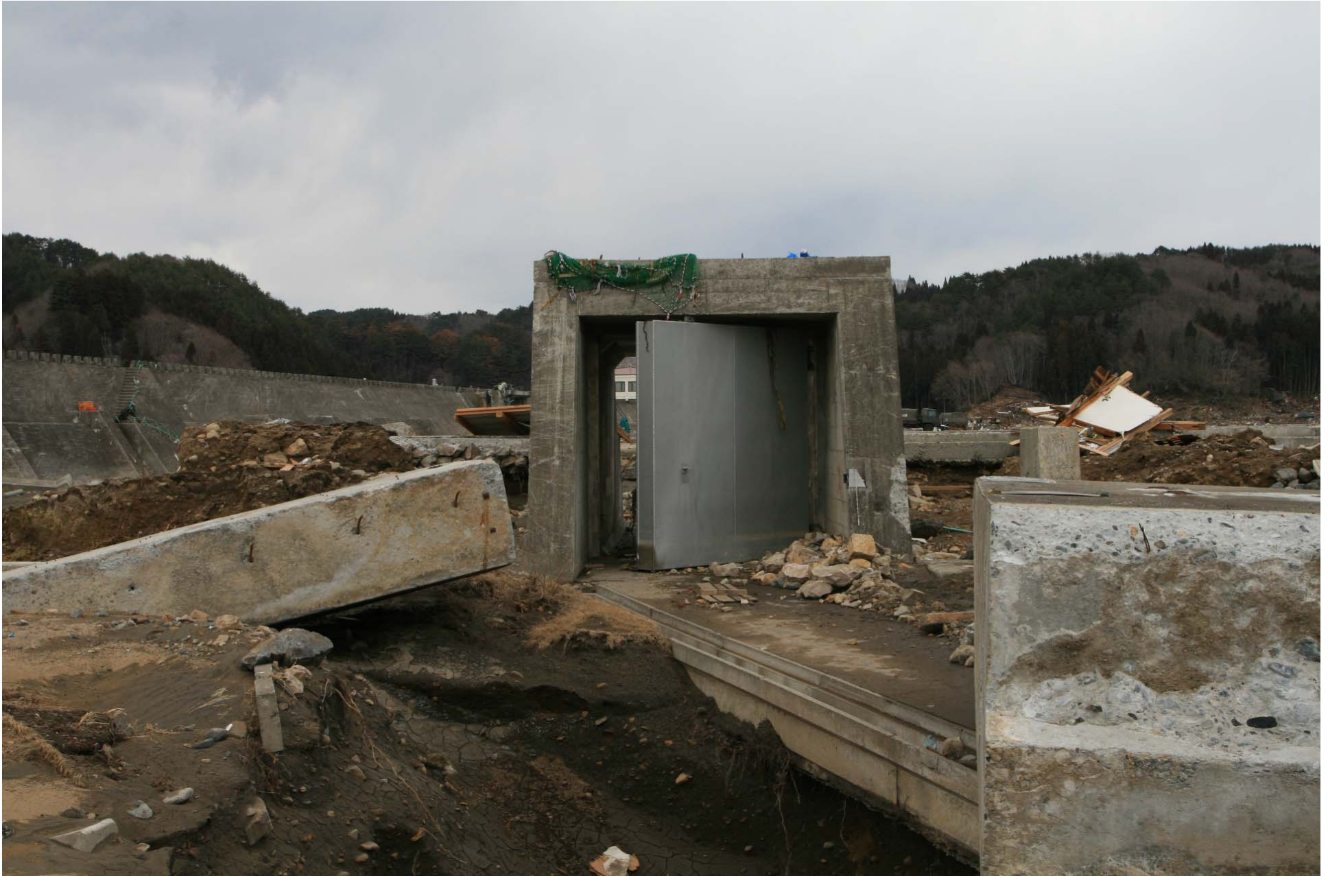
防潮扉・防潮堤の被災(田老地区)
