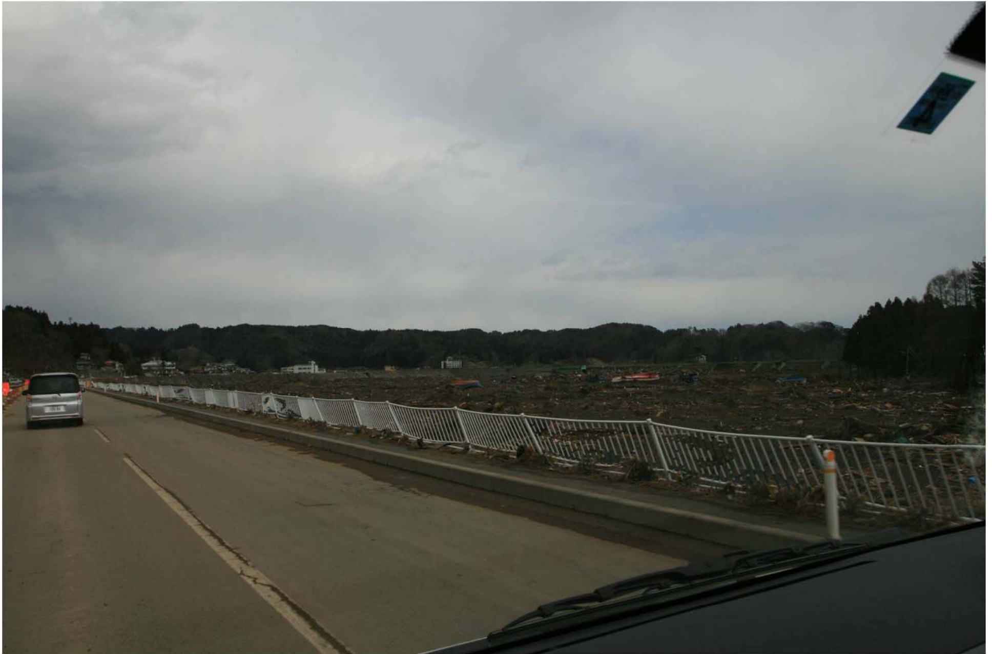
歩行者用防護柵の被災(田老地区国道45号)
