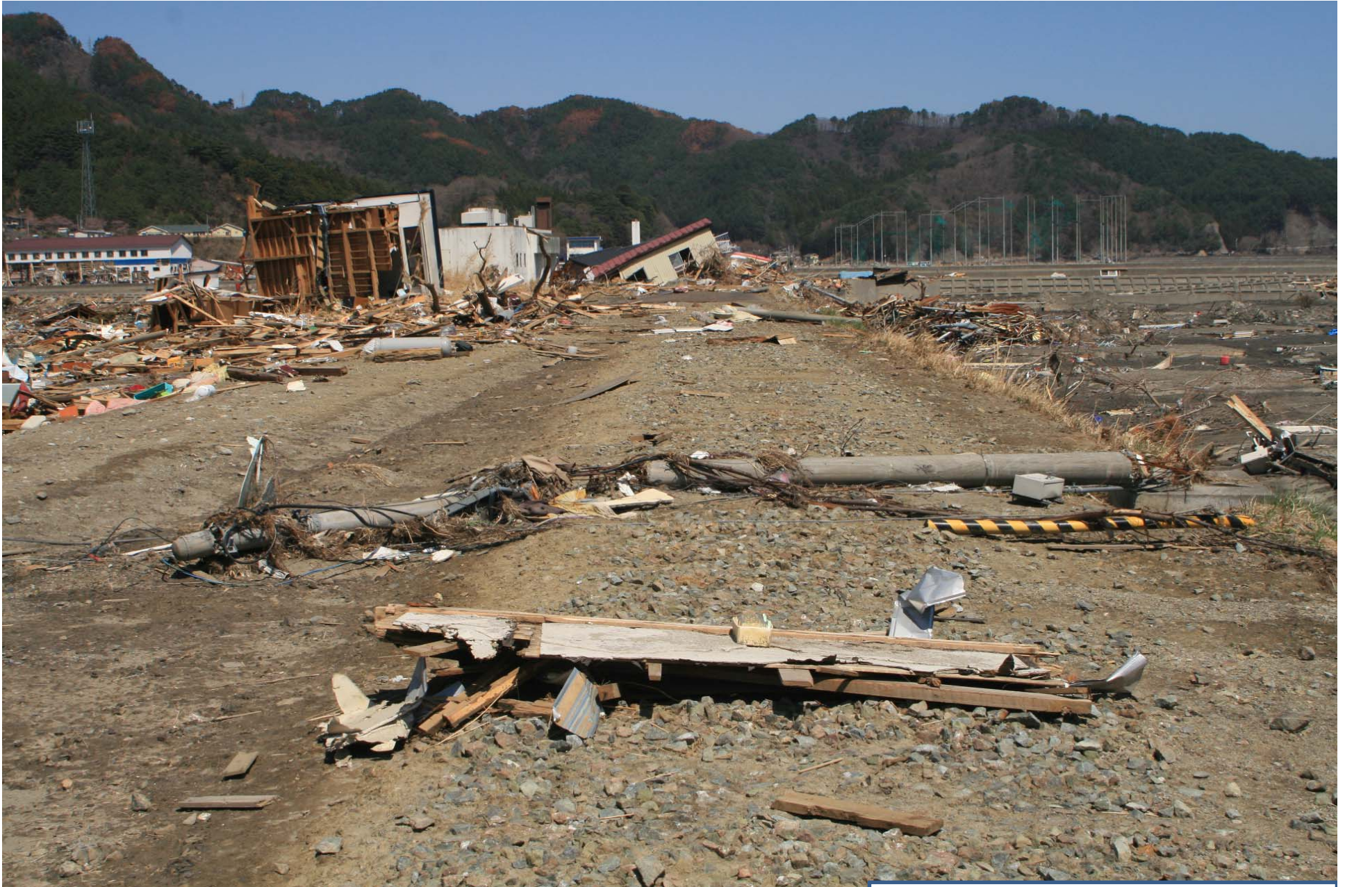
JR山田線鵜住居駅付近
