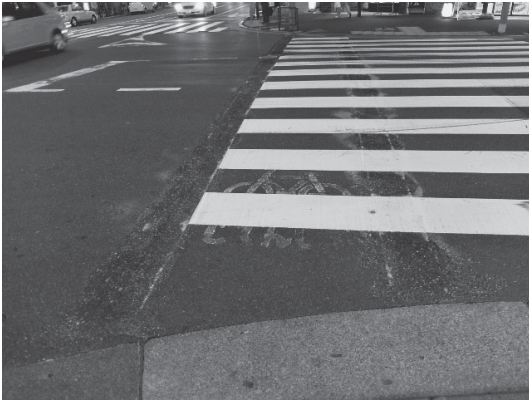
図-4 自転車横断帯の撤去跡（東京都内）
