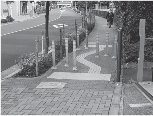
図-8 速度抑制のため設置されたバリカー（東京都内）
