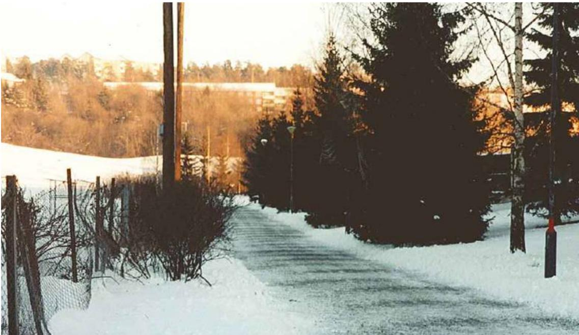
写真10 寒い気候で表面をならして砂を散布したところ（NPRA 提供）
