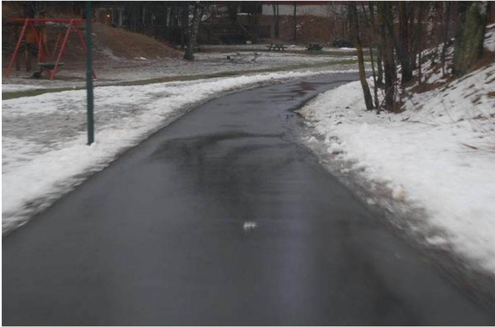
写真9 塩が散布された直後の自転車道（NPRA 提供）
